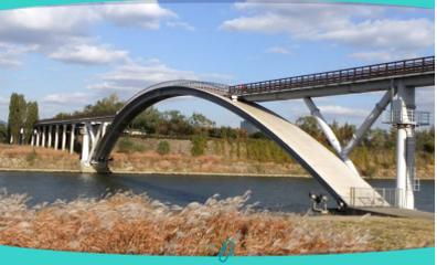
사실 고덕대교보다 먼저 슈퍼 콘크리트와 유사한 초고성능 콘크리트로 지어진 우리나라 다리가 있습니다. 바로 선유교인데요. 선유교는 양화한강공원과 선유교 공원을 곡선으로 이어주는, 보행만 가능한 아담한 다리예요. 하지만 순수 해외 기술로 지어졌습니다. 2002년 한불수교 100주년 기념으로 프랑스 기업과 연구소가 자국의 초고성능 콘크리트를 가져와 건설했습니다.
