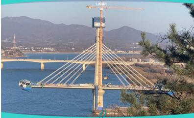
고덕대교가 완공되면 세계 최고의 콘크리트 사장교(교각 위에 세운 탑에서 케이블로 다리 상판의 하중을 지지하는 교량)로 등극합니다. 주 경간장(주탑 간 거리)이 540m로 세계 1위 이지요. (연: 제1호문예대 스카이라이프교 주탑간장 530m) 이 고덕대교 건설이 가능한 건 슈퍼 콘크리트의 국산 덕분이지요.
